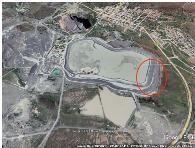
La presa de Jales de Jagersfontein como se presenta con fecha 2/8/21
