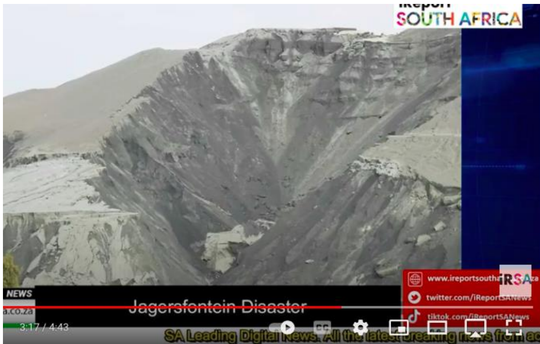
Se puede observar el talud muy saturado
