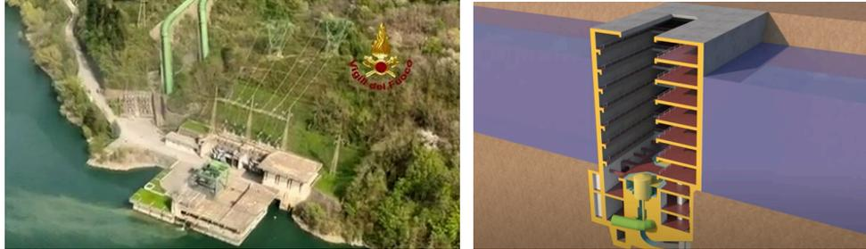
Dos tuberías de conducción de acero y unas tuberías de presión permiten el ingreso de 105 m<sup>3</sup>/s a las turbinas. Válvulas a esfera regulan el ingreso de las aguas a las turbinas. Los equipos principales, es decir las turbinas, los generadores y sistema de lubricación, se encuentran en el piso menos 8 y menos 9 de la planta.
